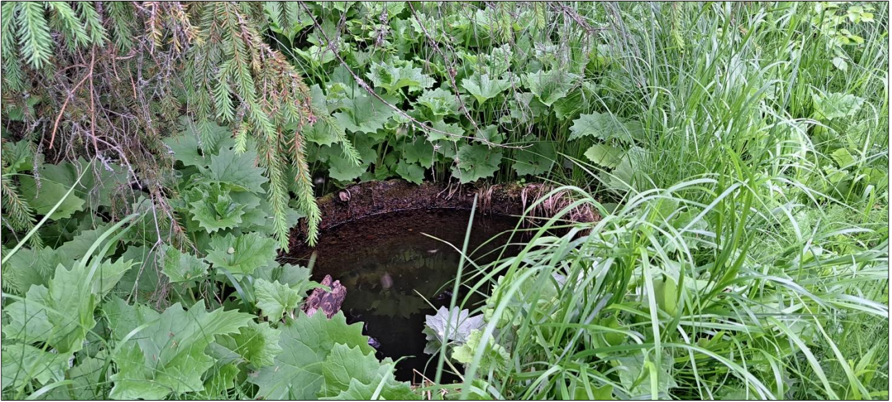
Kuva 19 Lähteellä on betonirengas ja kansi puuttuu.
