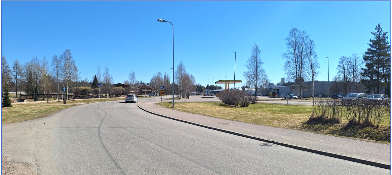
Kuva 17. Näkymä Toritietä etelään eläinlääkäritalon kohdalta.
