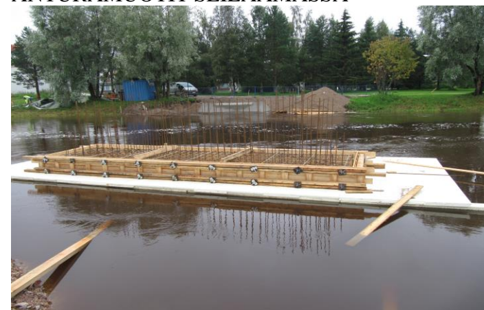
KESÄTULVA YLLÄTTI TYÖMAAN POHJOISPUOLEN 4-5.8.2012. ANTURAMUOTIT SEILAAMASSA
