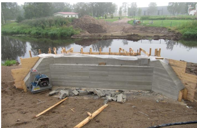
SILTA-ANTURASTA PURETTU MUOTIT POIS
