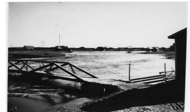
HÄKKILÄN SILTA NS. PUKKISILTA
