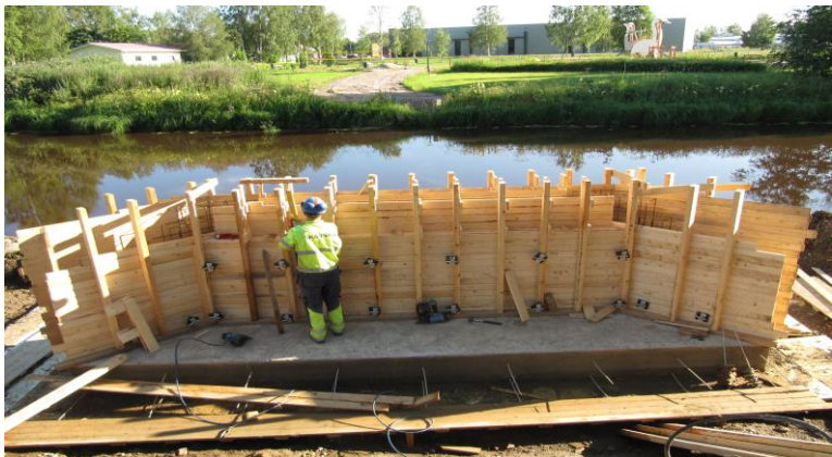
SILTA-ANTURAN SEINÄMIEN RAKENTAMINEN
