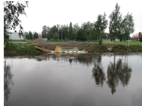
KESÄTULVA YLLÄTTI TYÖMAAN POHJOISPUOLEN 4-5.8.2012. ANTURAMUOTIT SEILAAMASSA
